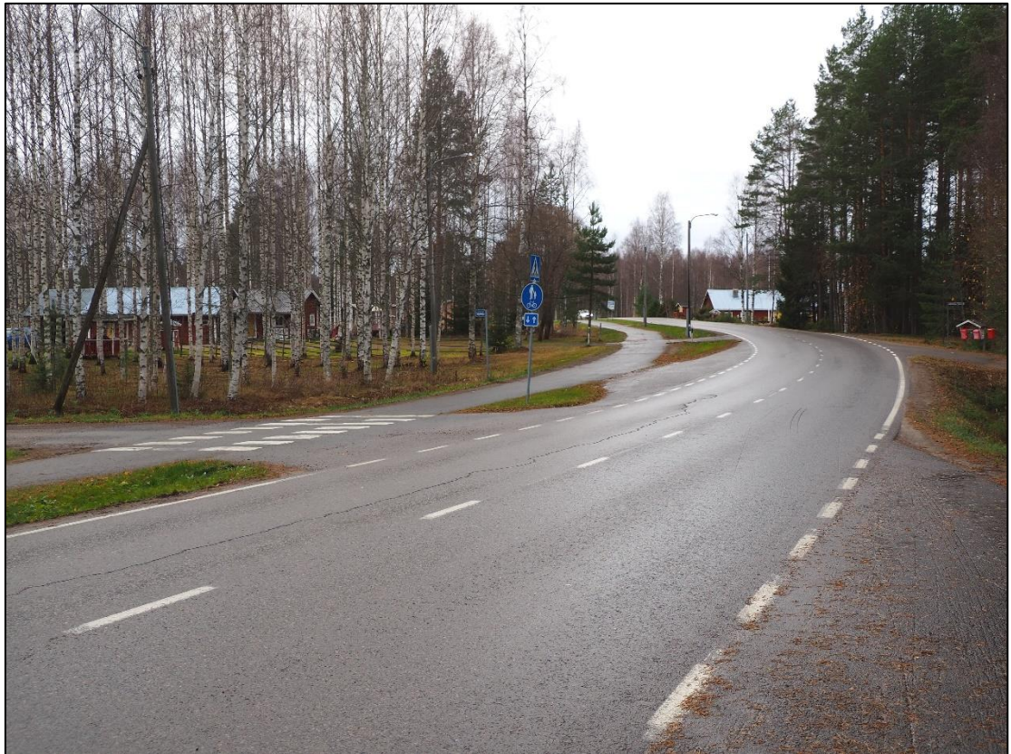
Kuva 12. Honkalehdontien katutilaa jossa on viherkaistalla ajoradasta erotettu jalankulun ja pyöräilyn väylä.
